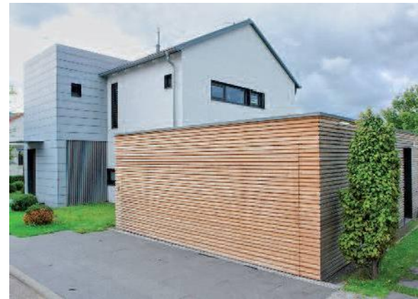
Flächenbündiges Kipptor mit Profil-Schalung aus Lärchenholz
