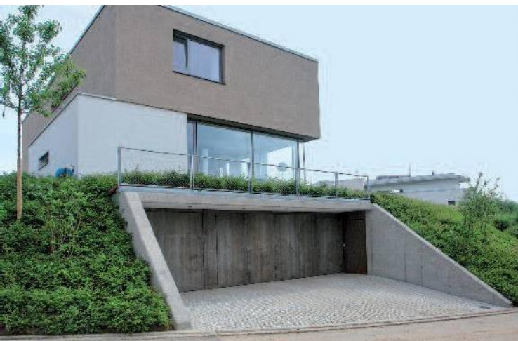
Kipptor bauseitig mit Cortenstahl verkleidet
