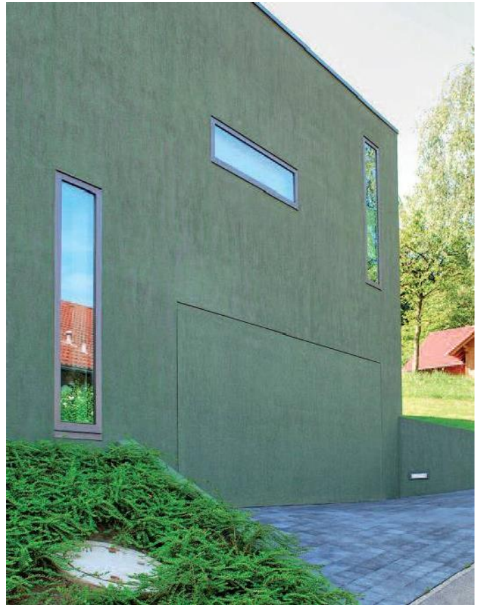
Das Tor wurde in den Vollwärmeschutz integriert und bauseitig mit Edelputz überzogen
